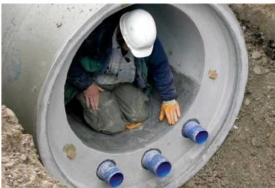
Dans le cas d'un réseau d'assainissement neuf ou lors d'une rénovation de tronçons, les échangeurs de chaleur peuvent être intégrés à la canalisation. Dans le cas inverse, les systèmes sont réalisés au cas par cas et déposés au fond des canalisations. Cependant, la mise en place de ce système, qui est aisée pour des constructions nouvelles, sera difficile et chère pour des canalisations anciennes et de petits diamètres.
