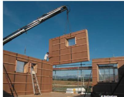
Le principe est de préfabriquer des caissons et de les remplir en atelier avec des bottes de paille. Le bâtiment peut ensuite être levé en quelques jours et la paille reste toujours protégée des intempéries.
