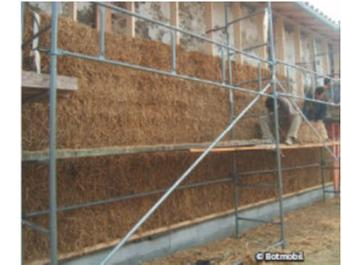
L'isolation thermique par l'extérieur permet d'isoler a posteriori, un bâtiment déjà construit. Les bottes de paille sont collées au mur existant ou bien sont insérées dans une ossature secondaire elle-même fixée au mur existant.
