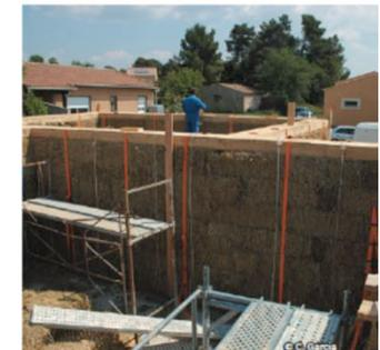
La botte de paille a ici un rôle structurel en plus d'être un isolant thermique. Il n'y a pas d'ossature bois, ce sont les bottes de paille qui portent la charpente.
