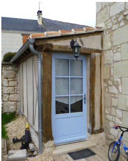
Les travaux se sont achevés en 2010. De faibles remontées capillaires sont constatées dans le tuffeau au niveau du sol malgré le drain qui court tout autour de la maison. Il est souvent préférable d'utiliser des pierres plus dures que le tuffeau pour les parties des murs soumises aux intempéries. Cela a été fait, ici, pour les seuils et les appuis qui sont en pierre de Hains et de Migné.
