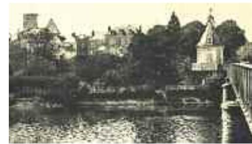
Vue du pont, l'église sans toit après l'incendie de 1921.
